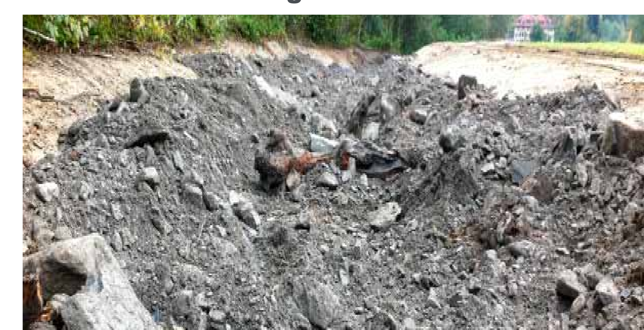
Bauphase, Oktober 2011, Gerinnegestaltung
